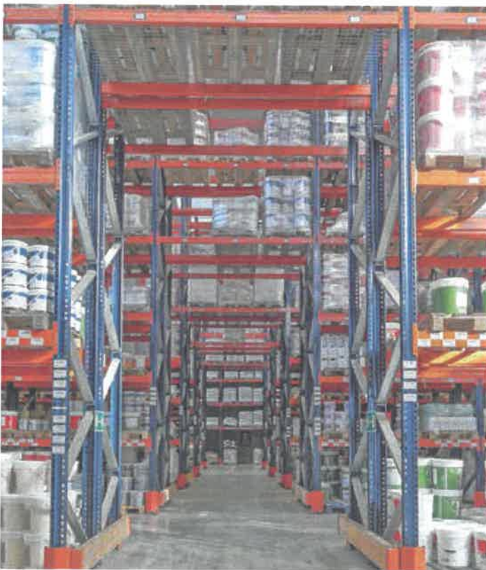
Installation avec allée pont
