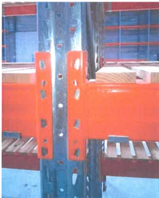
Liaison lisse/montant avec goupille
