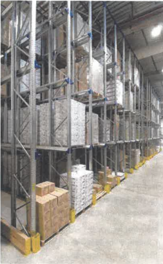
Installation de stockage à accumulation
