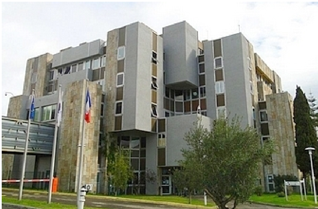
Façade de l'Hôtel de Police
