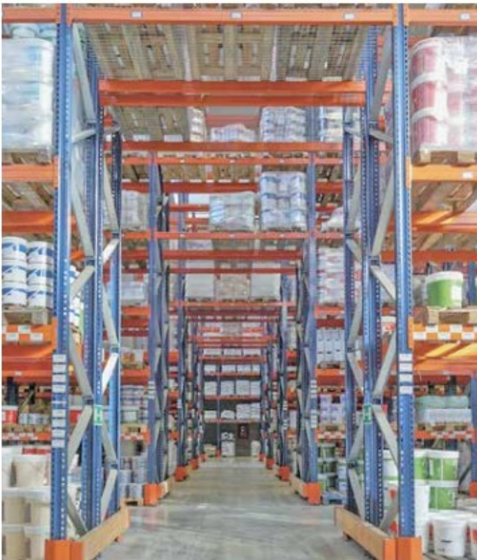
Installation avec allée pont
