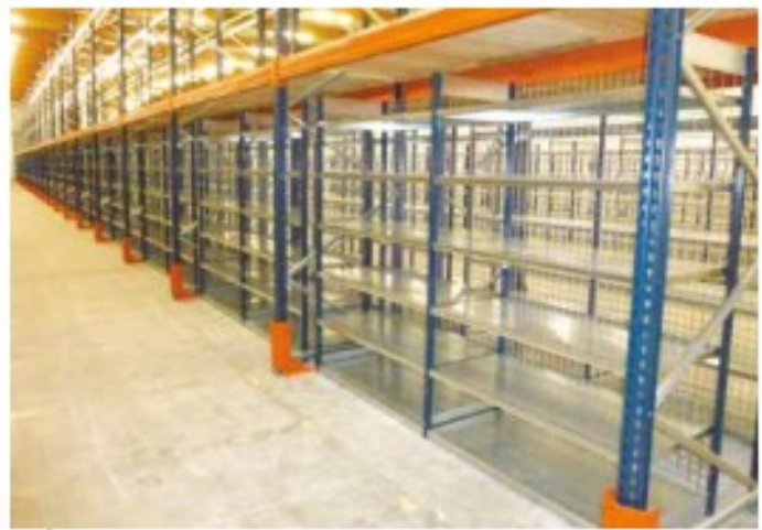
Plancher plein au-dessus d'étagères
