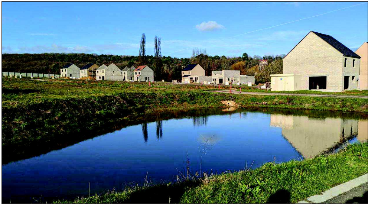
Figure 8 Illustration d'un bassin d'infiltration
