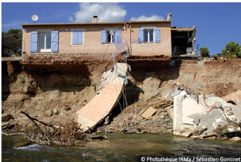
Inondations du Var - érosion des berges de la Nartuby - 2010.
