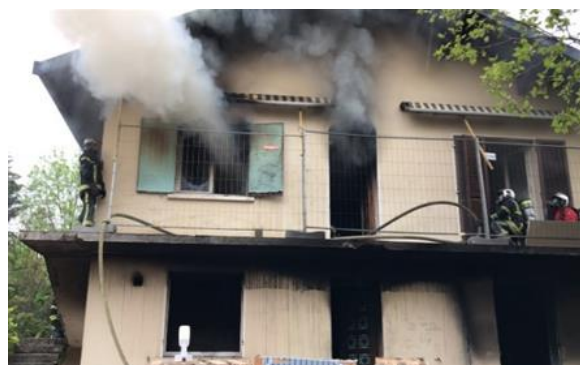
Exemple d'action d'hydro-ventilation
