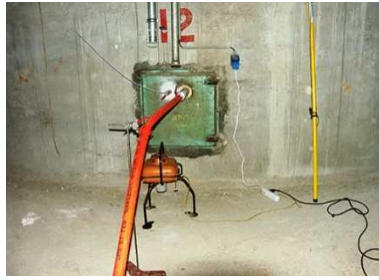
Raccord pour inertage en pied de cellule.
