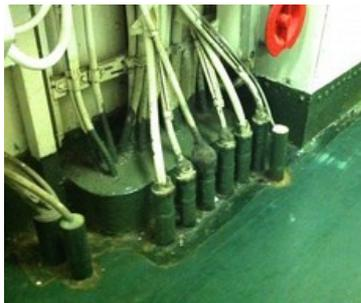
Presse étoupe permettant d'obtenir l'isolement au feu et à l'eau d'un pont.
