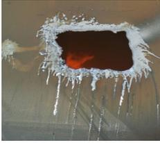
Plusieurs types de matériels de découpage peuvent être utilisés : lance thermique, oxycoupage. Ces outils permettent de créer des ouvertures sur un navire. Ces percées peuvent être pratiquées sur le bordée ou un pont.
