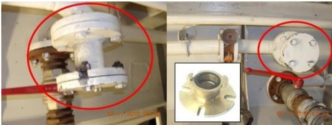
**Vanne à détaper pour permettre l'alimentation du collecteur incendie par une source extérieure.**
