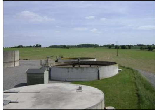
Installation de traitement
