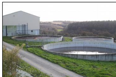
Fosses semi enterrées Photo : chambre d'agriculture du Finistère
