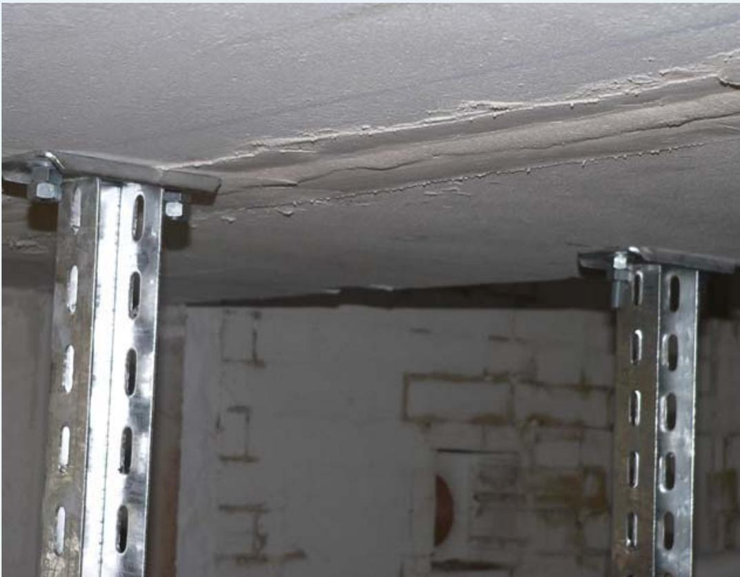
**Photographie 3 : Détail du pendard permettant la fixation des chemins de câbles sur la rehausse**
