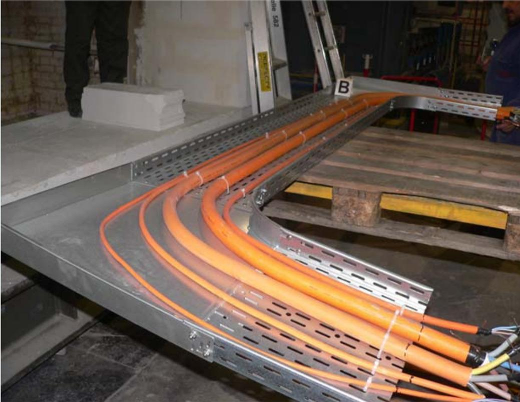
**Photographie 2 : Exemple de fixation des câbles sur chemin de câbles en U**
