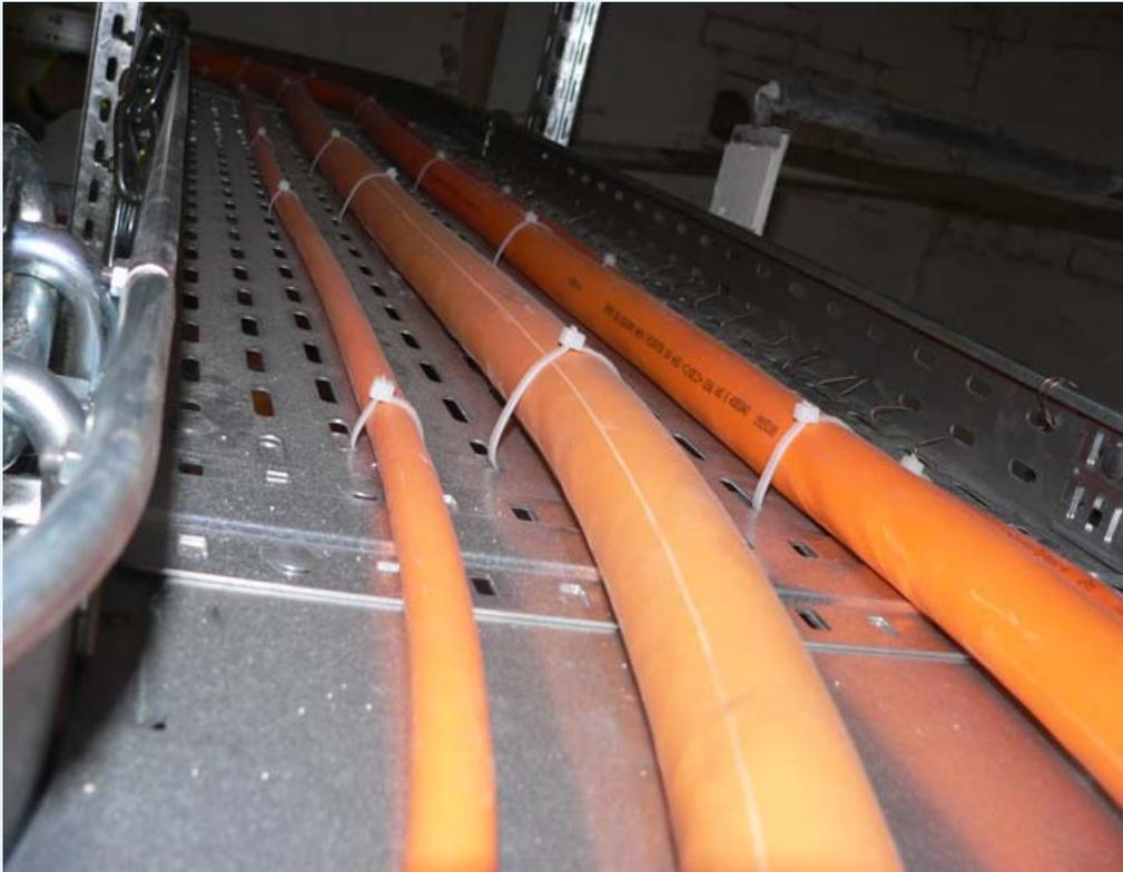
**Photographie 1 : Détail de fixation des câbles et des chaînes et positionnement d'un des thermocouples**
