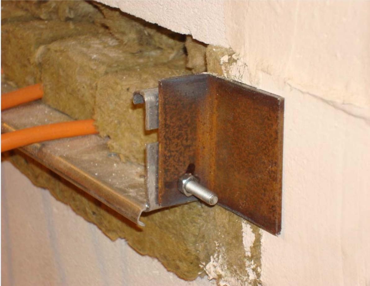
Photographie 7 : Vue générale en sortie de rehausse, calorifugeage et équerre non fixée dans le mur.
